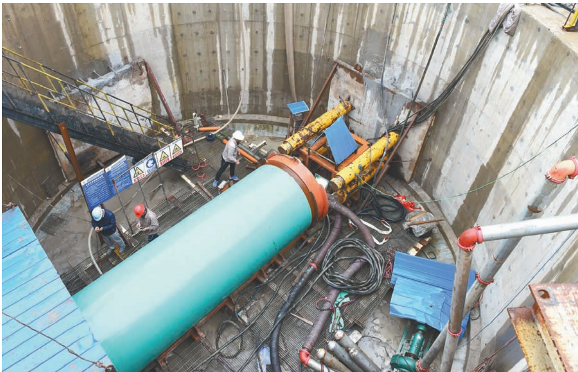
11月16日,盐都龙冈境内新水源地三标段建设工地一派繁忙,工程建设者正在进行顶管作业。新水源地及引水工程是我市头号为民办实事工程,也是盐城历史上最大的跨区域引水工程,该项目将长江水从京杭大运河引入我市,受益人口近500万人。
